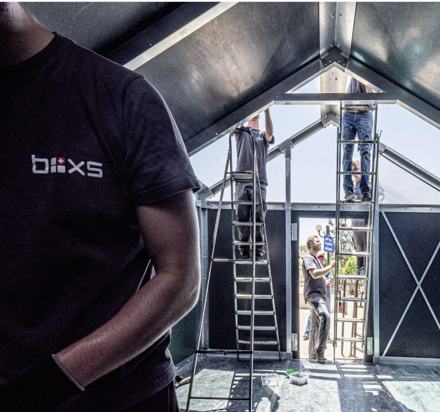
Ein Haus aus Recyclingplastik wird in Jordanien aufgestellt. Für den Aufbau werden weder Werkzeuge noch Strom benötigt.
